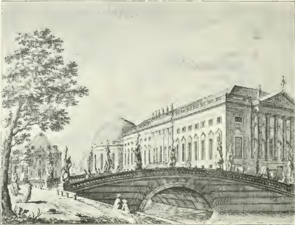
Opernhausbrücke mit den Statuen von W. C. Meyer 1776.
